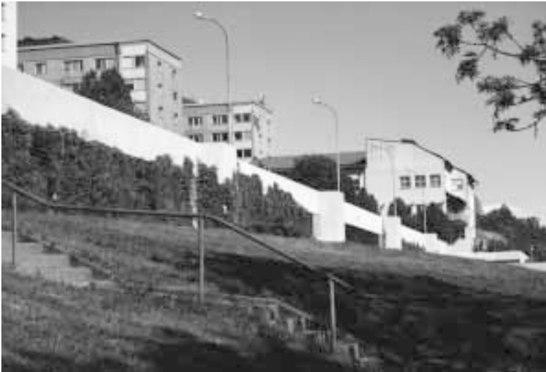
Bild 41: Hjällbo Lillgata är högt beläget och delvis ombyggt för förvaltningar, till höger Gatukontoret.
