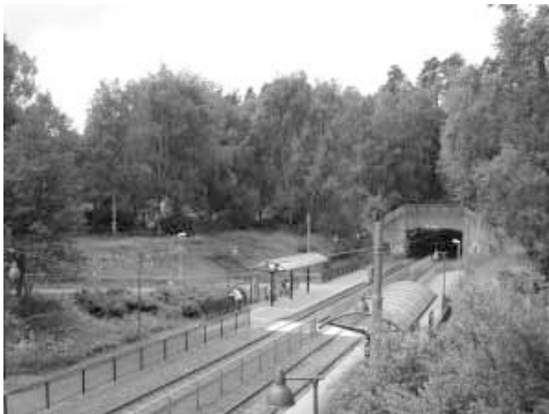
Bild 26. Rymdtorgets hållplats efter ombyggnad. Ny markbeläggning, nya väderskydd, mur utsmyckad med betongplattor tillverkade av skolbarn. Till höger i bild syns hisstornet.
