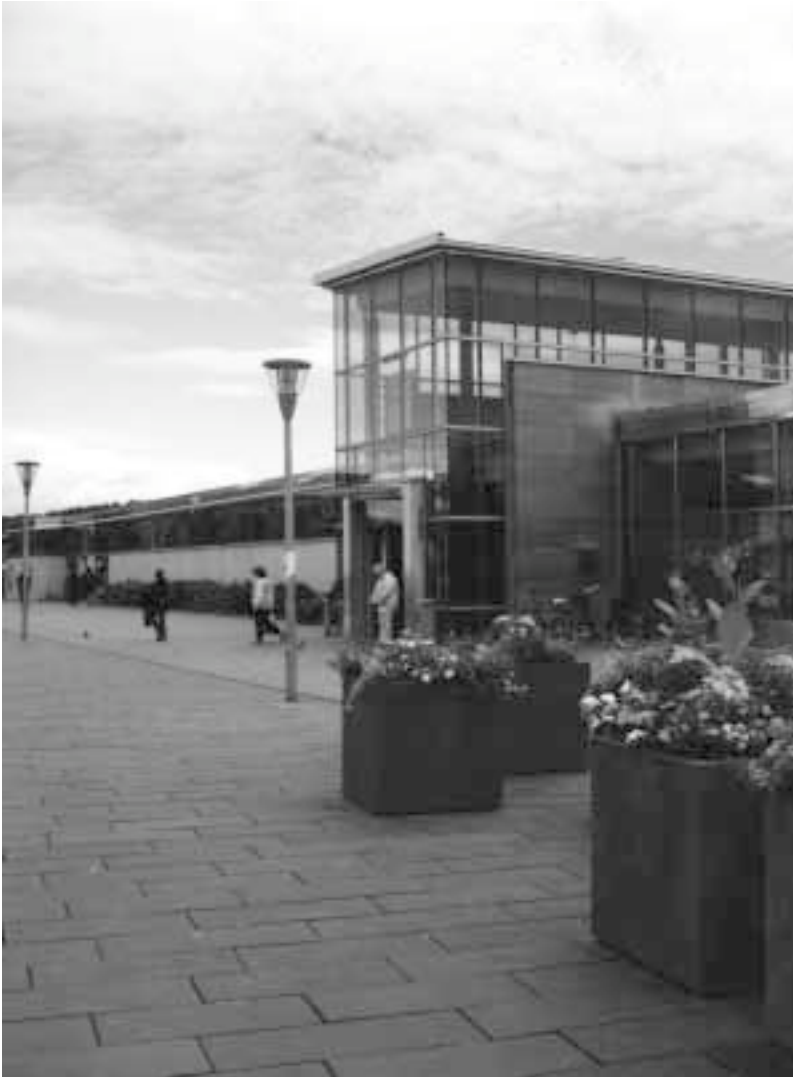
Bild 37. Den nya centrumbyggnaden som förbinder torget och parkeringen.
