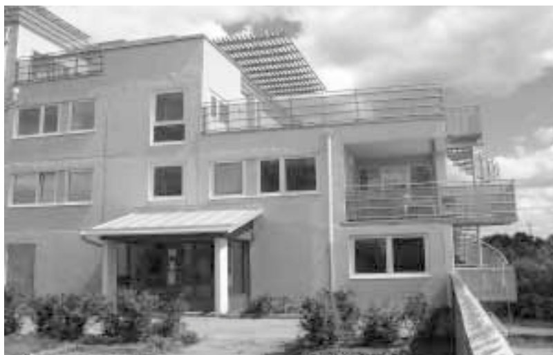
Bild 31. De nyskapade terrasshusen i västra Gårdsten.
